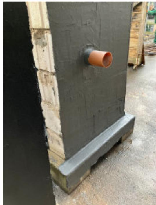
*Bild: Wandscheibe, an der die Abdichtung erdberührender Bauteile mit flüssig aufzubringenden Abdichtungen (MDS, FPD und PMBS) entsprechend DIN 18533 im Abdichtungsschein geübt wird*
